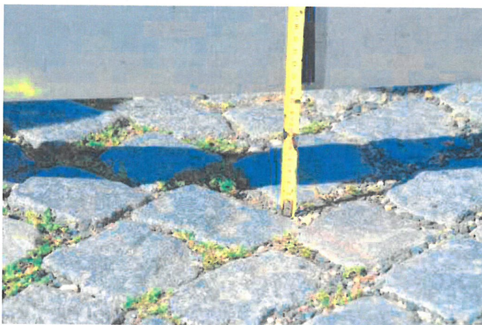
Obrázek 5 Detail deformace v místě vedení inženýrských sítí
